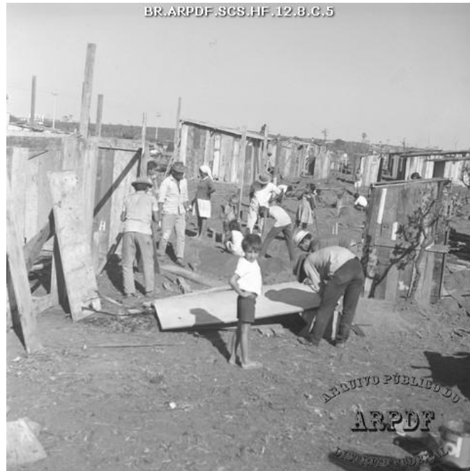
Figura 15 - Construção de barracos em Ceilândia DF, 09 de junho de 1971, Foto Joaquim Firmino. Fonte: Arquivo Público DF
