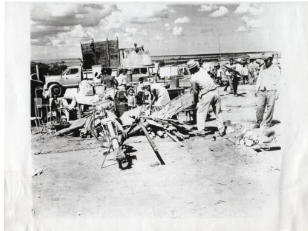
FOTO: TRANSFERÊNCIA DOS BARRACOS - 1971
