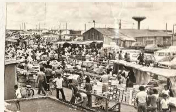
Foto: [1] Início da cidade de Ceilândia - Foto Internet
